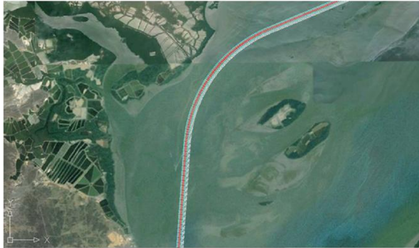
Figura 3 Zona de los Farallones, comprendida entre la Boya 17 (31+600 km) y la Boya 33 (46+900)
